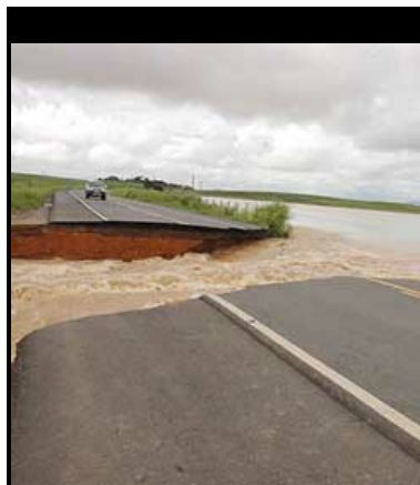
O rompimento de um dique abre cratera na rodovia BR-356, em Campos dos Goytacazes, no Rio
